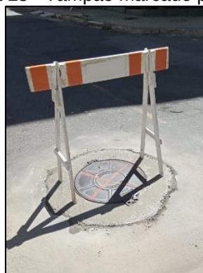
Figura 15 - Tampão marcado para fácil localização
